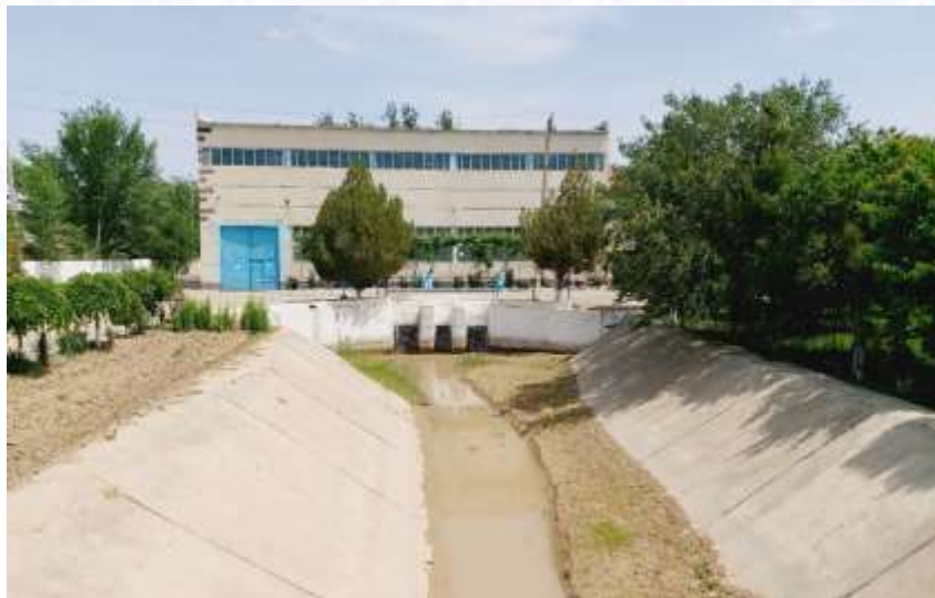
1.2-rasm. Nasos stansiya avankamerasidagi suv qabul qilish inshooti
