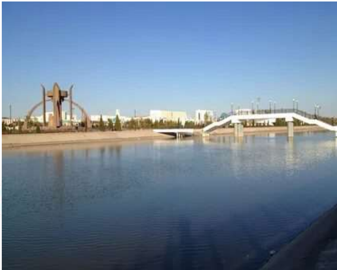
1-Shovot kanalining umumiy ko'rinishi
