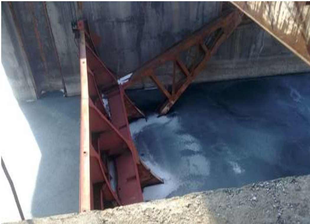
2-rasm. Gidrouzel zatvorining muzlash holati.
